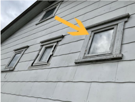
Dette vinduet er ikke synlig fra innsiden.
