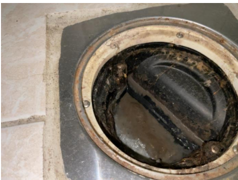
Plastsluk uten tettesjikt underklemring.
