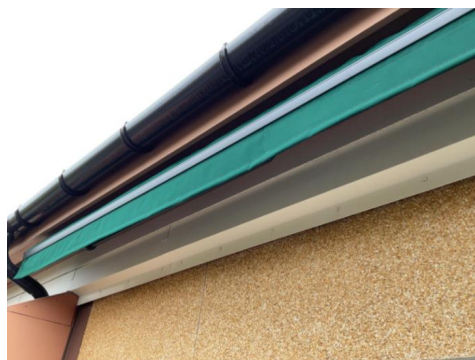
Motorstyrt markise montert i 2026.
