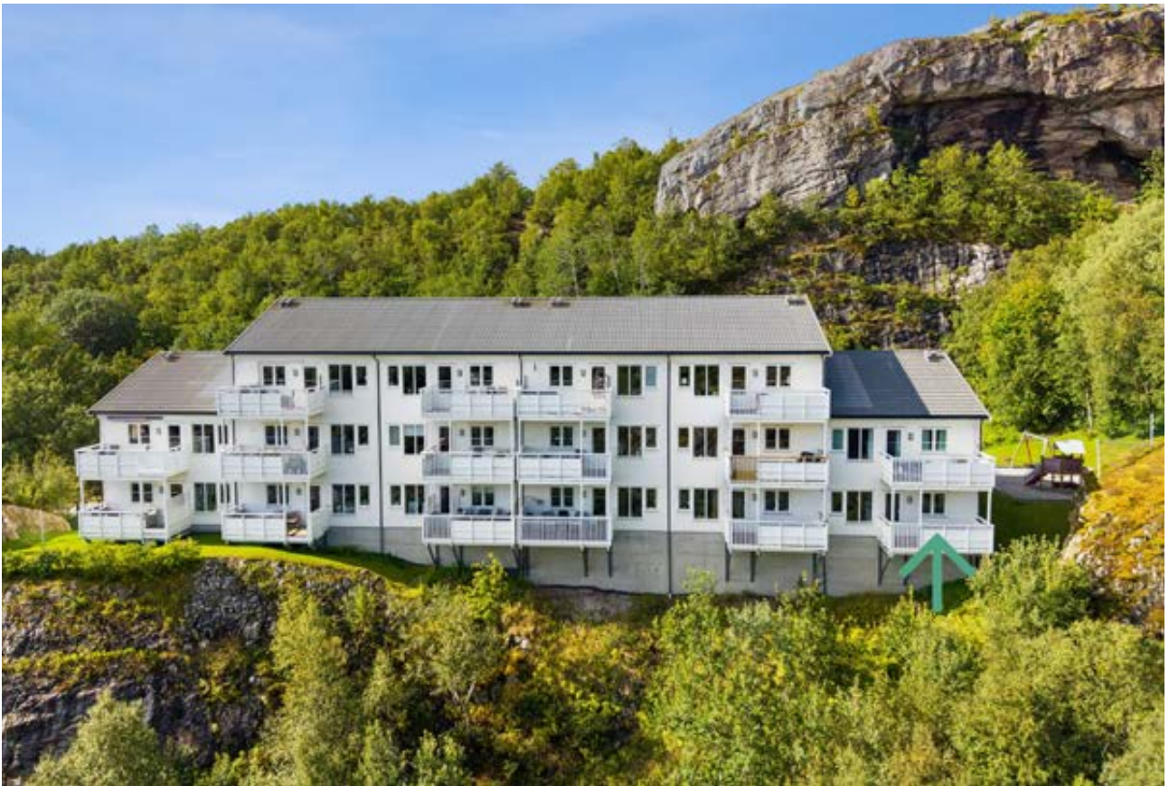
Bolde av hele leilighetsbygget- leiligheten ligger i 1 etasje, lengst til høyre
