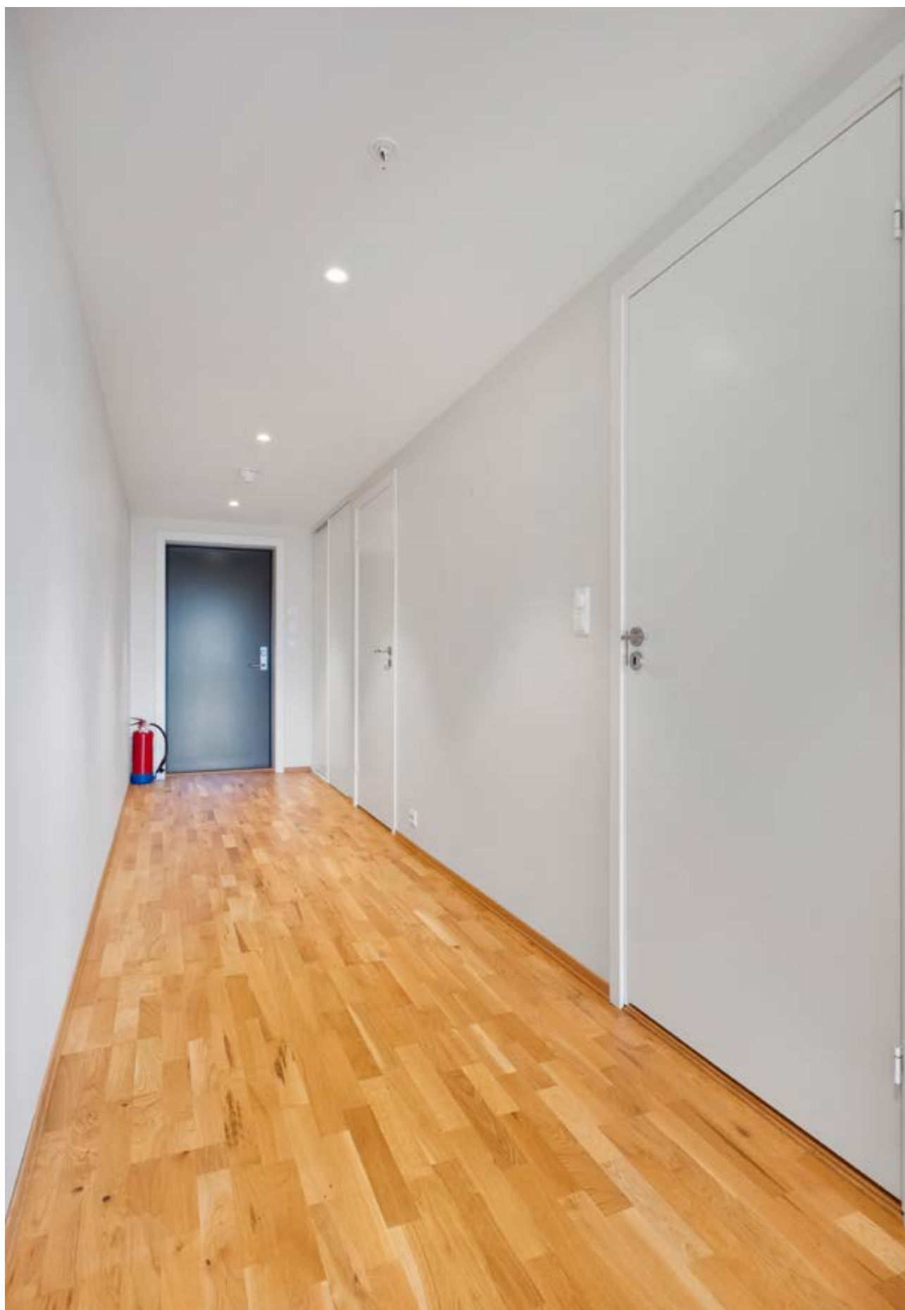
Vannbåren varmelegg som forsyner gulvvarme til stue/kjøkken, bad og gang
