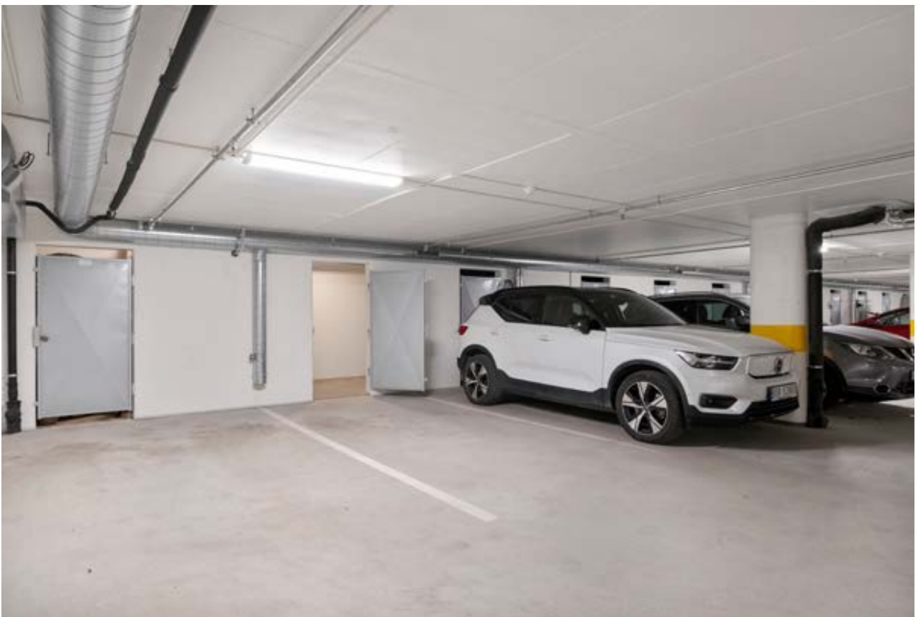
Leiligheten har egen parkeringsplass. Bod i bakkant av parkeringsplassen
