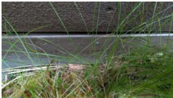
Bordkledning går stedvis nesten helt ned i terreng.
