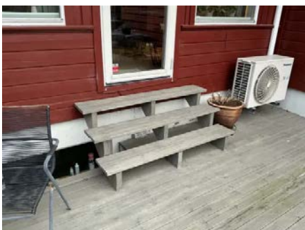
Rekkverk på trapp fra stue er ikke etablert.
