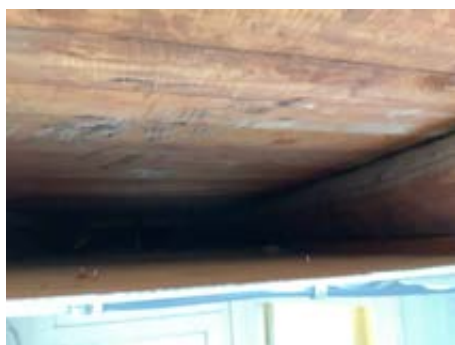
Uisolerte etasjeskille
