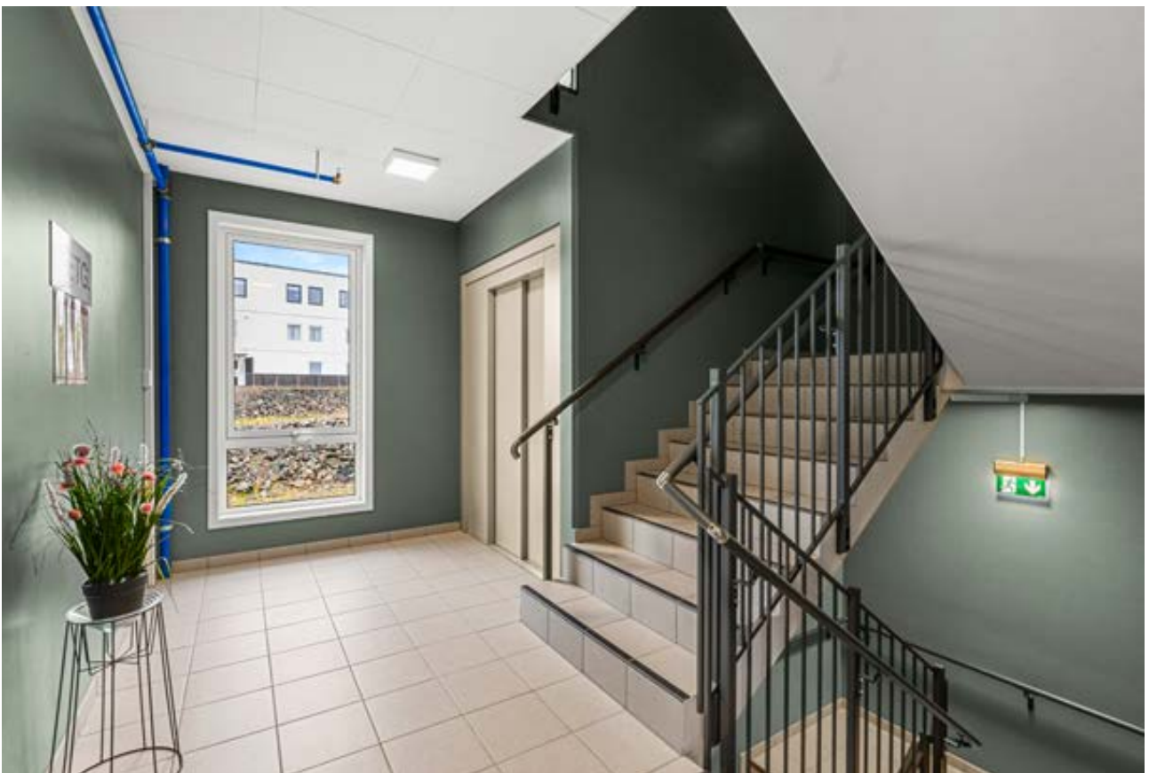
Heis i bygget
