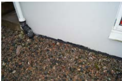
Oppgradert/forbedret drenasje rundt bygning i 2017
