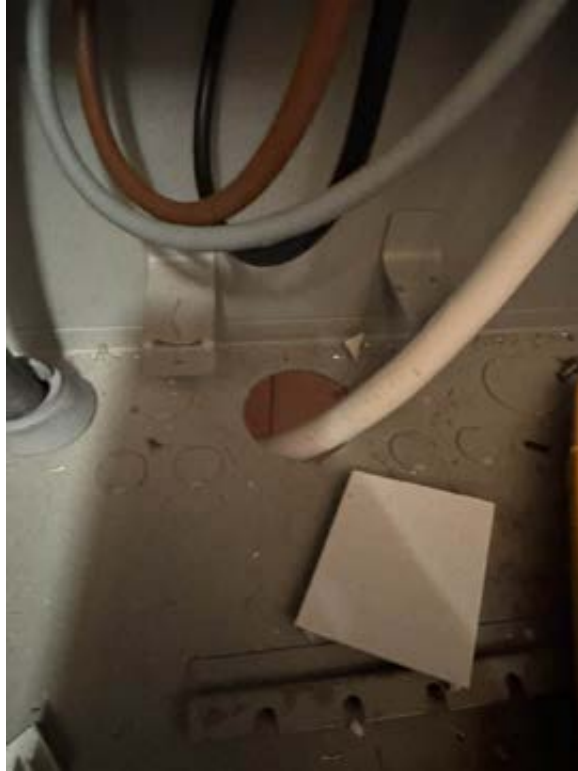
Skjema: "NELFO Per. kontr. Bolig S1" Spørsmål: Neste periodiske kontroll Beskrivelse: Bilder avvik 13, Filnavn: Mangler nippel.jpg
