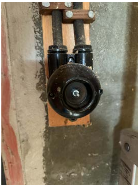
Skjema: "NELFO Per. kontr. Bolig S1" Spørsmål: Neste periodiske kontroll Beskrivelse: Bilder avvik 6, Filnavn: Defekt bryter.jpg
