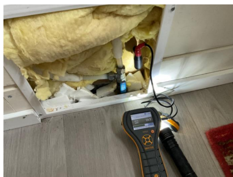
Fuktsøk i vegg via inspeksjonsluke, ikke utslag på fukt.
