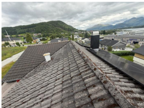
Oversiktsbilde av takteking.
