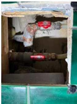
2 x stoppekraner i baderomsvegg bak luke
