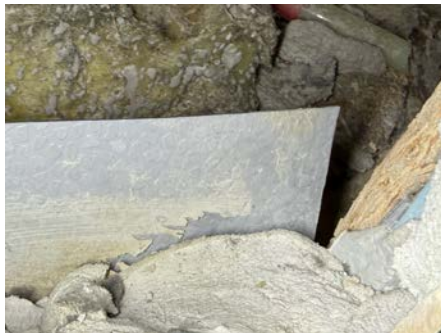
Synlig banemembran i baderomsgulv bak luke på bad
