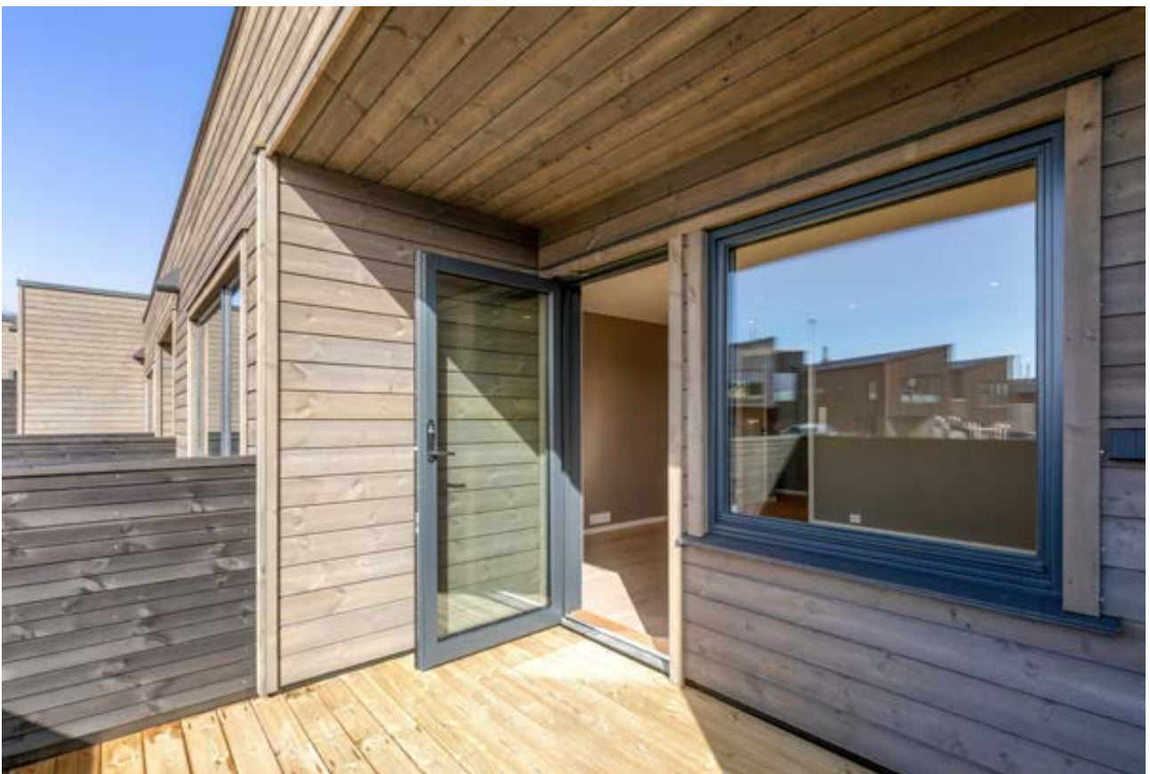
Treverk i konstruksjonen gir en varm og naturlig ramme rundt uteområdet.
