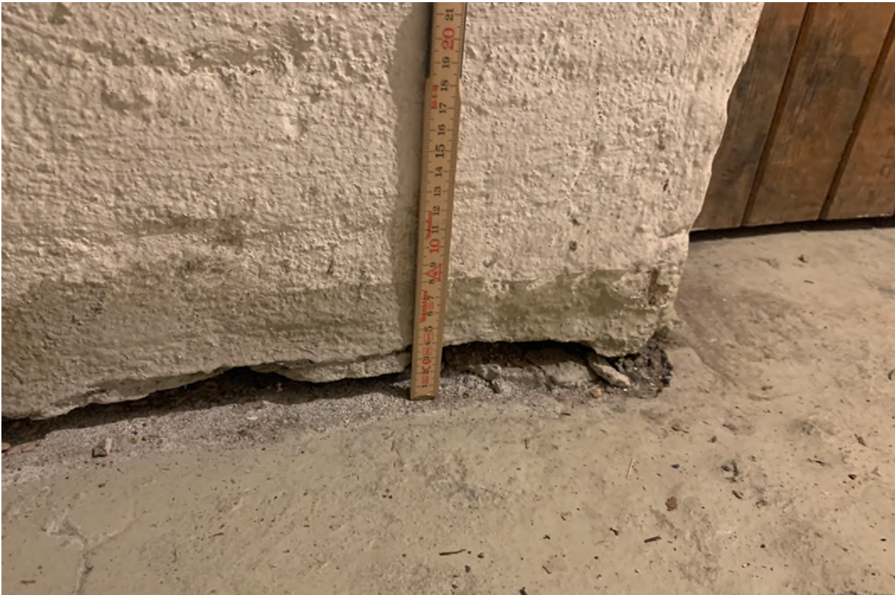
Bilde 9 Viser innervegg i kjeller hvor gulvet har sunket 2-3 cm i Vøyensvingen 1B. Årsak til setninger av gulvet er trolig utvasking av masser. Det er bærende vegger, som yttervegger, innervegger og gavlvegger som er fundamentert på pilarer til fjell. Deler av kjellergulvet hviler på løsmasser og vil følge eventuelle setninger.
