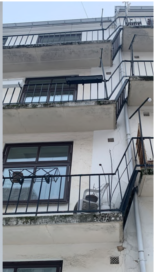
Bilde 7 og 8 Viser gjennomgående riss i yttervegg ved gateside og mot bakgård. Det er også riss i brannbalkonger som kan skyldes spenninger fra bevegelser i bygget. Riss i bakgård følger en mer rett linje ved gavlvegg fra loft til første etasje mot Vøyensvingen 1C. Ved gateside går riss 1,5 meter ned før det stopper og gjenoppstår i underkant av vinduer.
