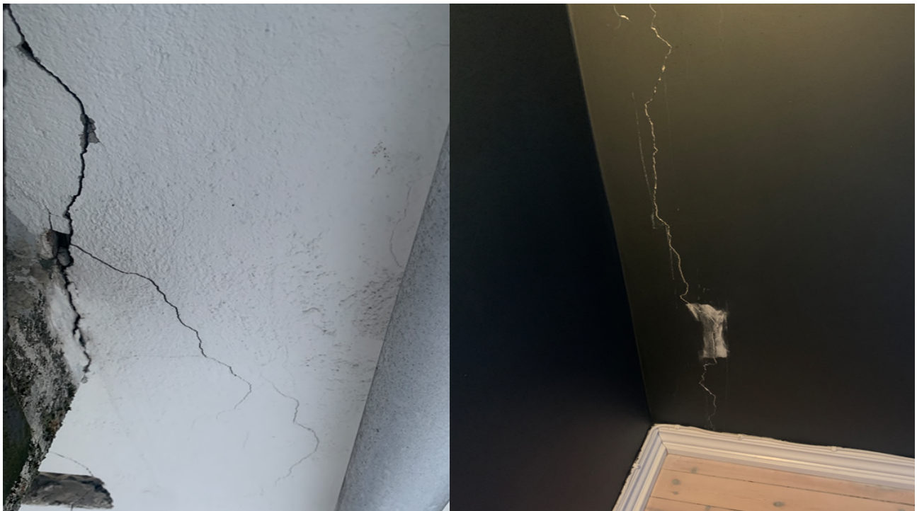
Bilde 3 og 4 Viser gjennomgående riss i yttervegg mot bakgård fra utside og innside..
