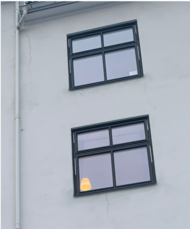
Bilde 7 og 8 Viser gjennomgående riss i yttervegg ved gateside og mot bakgård. Det er også riss i brannbalkonger som kan skyldes spenninger fra bevegelser i bygget. Riss i bakgård følger en mer rett linje ved gavlvegg fra loft til første etasje mot Vøyensvingen 1C. Ved gateside går riss 1,5 meter ned før det stopper og gjenoppstår i underkant av vinduer.
