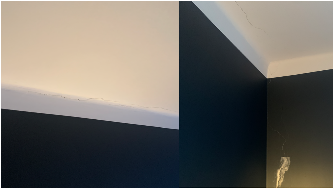
Bilde 5 og 6 Viser gjennomgående riss i yttervegg mot bakgård fra utside og innside. Riss går også langs himling. Det er uklart om etasjeskille mellom 4. etasje og loft er støpt betongdekke eller trebjelkelag med stubbeloftsleire og pusset underside.
