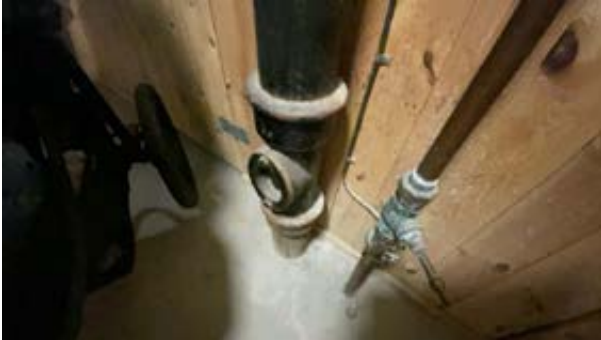
Stakepunkt i felles kjellergang.
