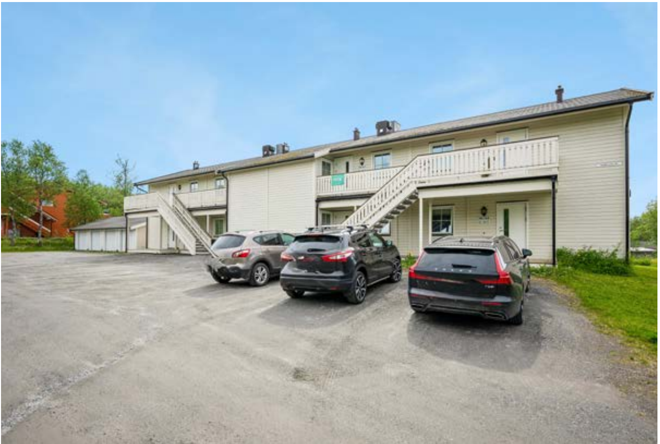
Gårdsplass og trapp opp til 2 etasjen og leiligheten
