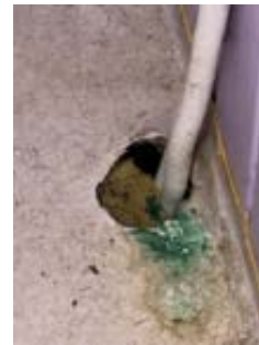
Rørgjennomføringer i gulv bak dusjkabinett.
