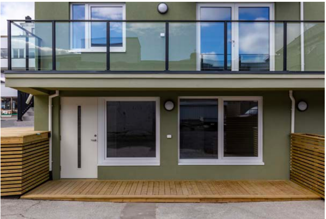
Ved inngangen er det egen terrasse
