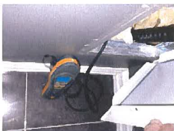
Hulltagning og fuktsøk
