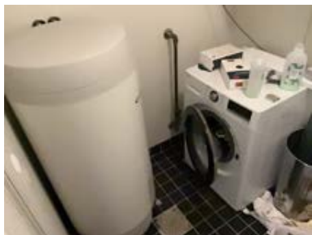
Vadkerom i underetasje
