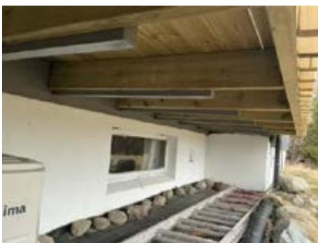
Bjelker til balkong med adkomst fra soverom er festet til bjelker fra byggeår.
