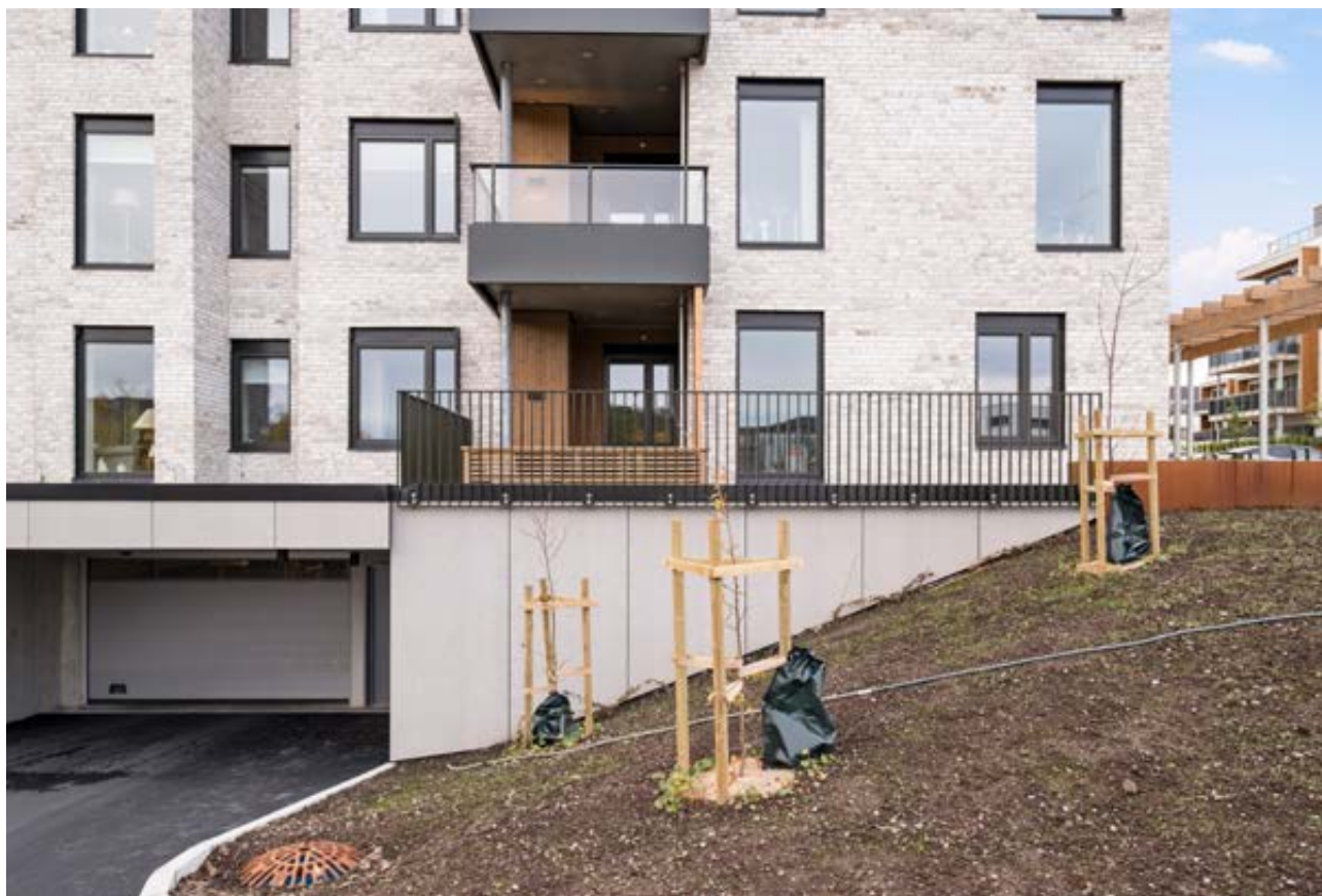
Inngang til garasjeanlegget.
