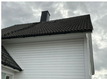
Pipe er dekket med beslag over tak.
