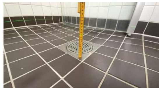
Høydeforskjell (ved sluk)
