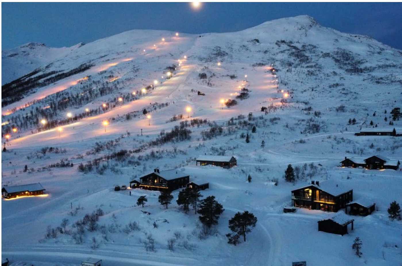
Ladelia har ski in/out - Bygg 1 og 3 er ferdig. Ladelia vil bygget i midten
