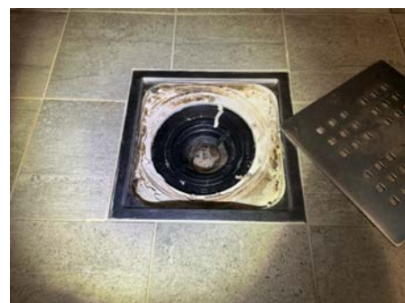
Sluk dusjsone i bad i 1.etasje
