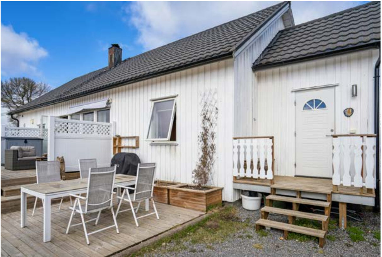
Inngangspartiet og plattning
