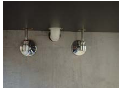
Vann/avløp til/fra servant. Åpent hull i vegg
