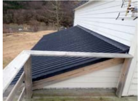
Tak over inngangsparti
