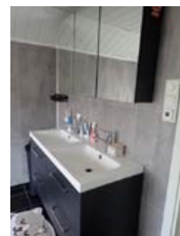
2 x servanter over innredning
