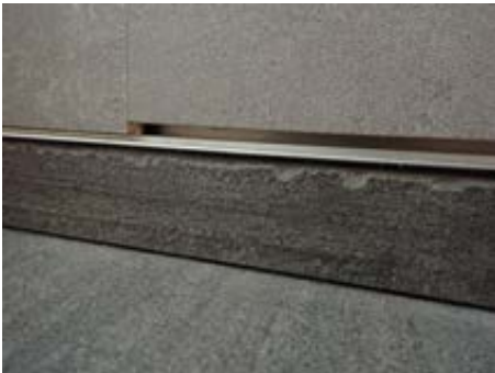
Store avvik - åpning mellom aluminiumsflit og veggplate.
