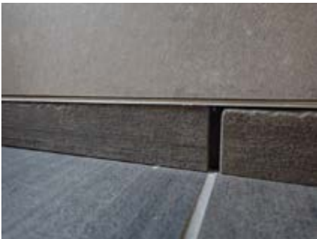
Store avvik - åpning mellom aluminiumsflit og veggplate.
