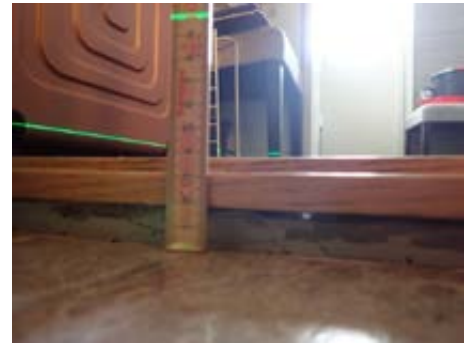
18 mm mellom flis og dørstokk Ikke synlig membran.
