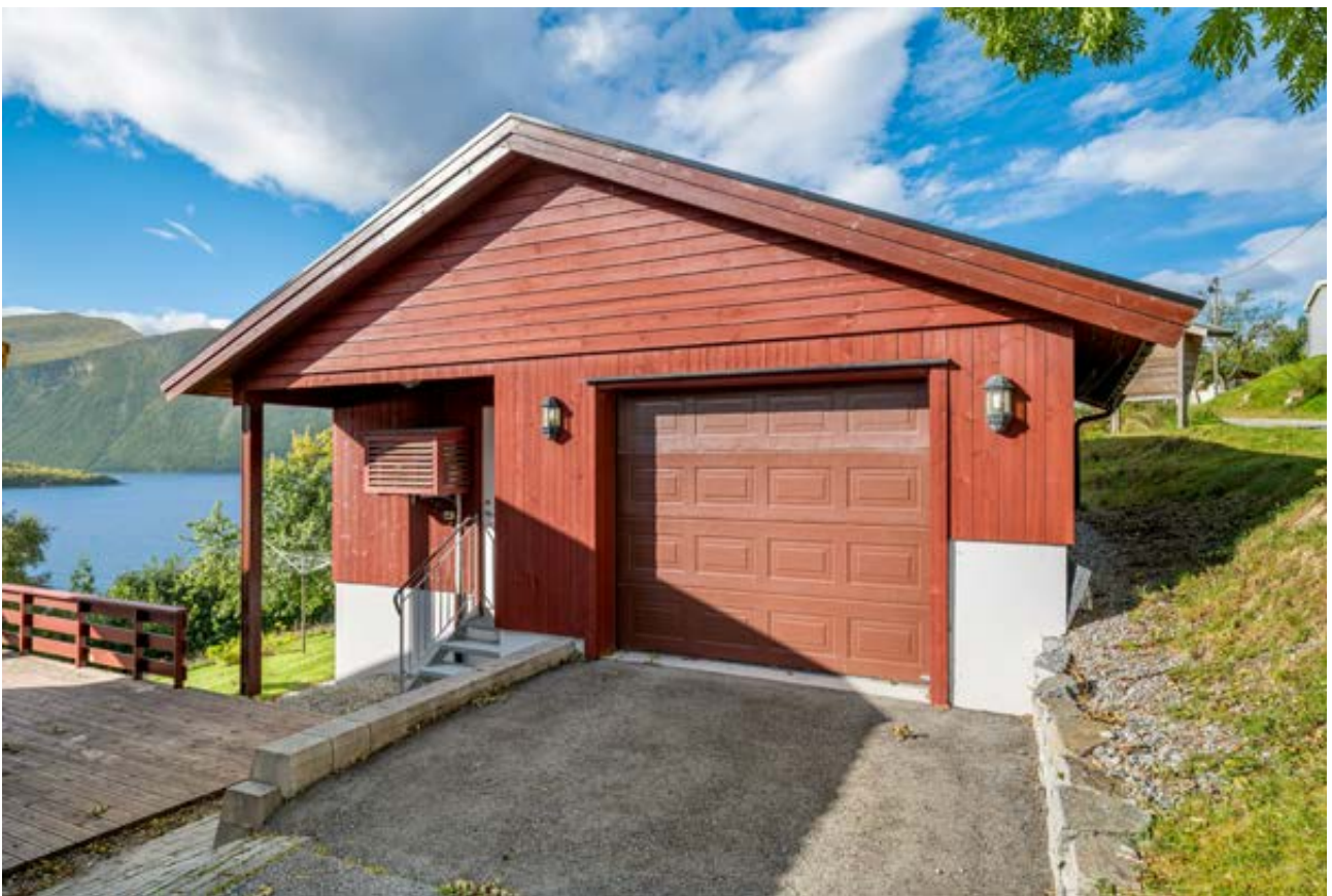
Romslig garasje med elektrisk garasjeport
