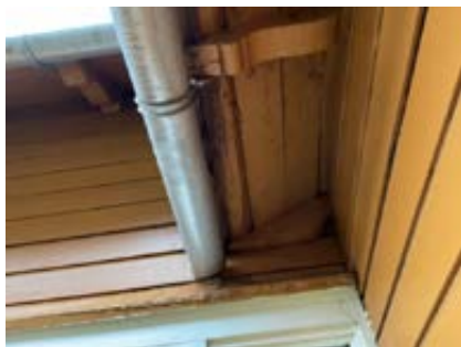
Fukt/råteskade taktro
