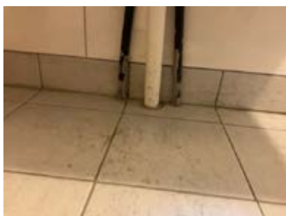
Rørgjennomføringer gulv
