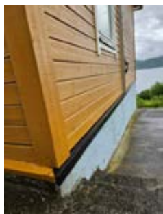
03.07.25: Bilder etter utbedring vannbord/beslag overkant mur, nordvest
