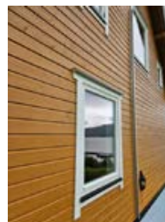
03.07.25: Bilde etter utbedring, oversiktsbilde eksempel vindu nordvegg.
