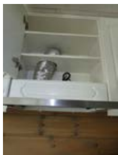
Ventilator med avtrekk ut i yttervegg
