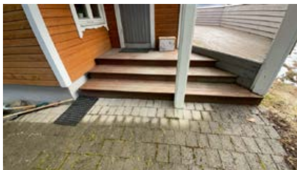
Trapp ved inngangsparti.
