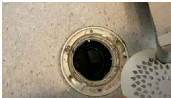
Plastsluk med klemring.
