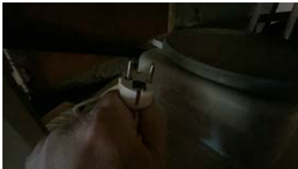
Ingen svimerker på stikk ved dagens befaring.
