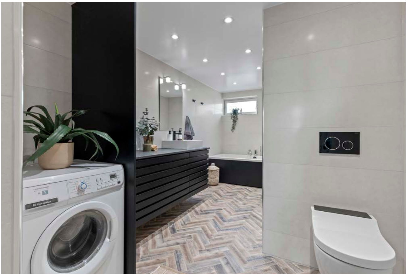
Nisje med opplegg for vaskemaskin/tørketrommel. Elektrisk styrt vifte. Tilluft via dørterskel.
