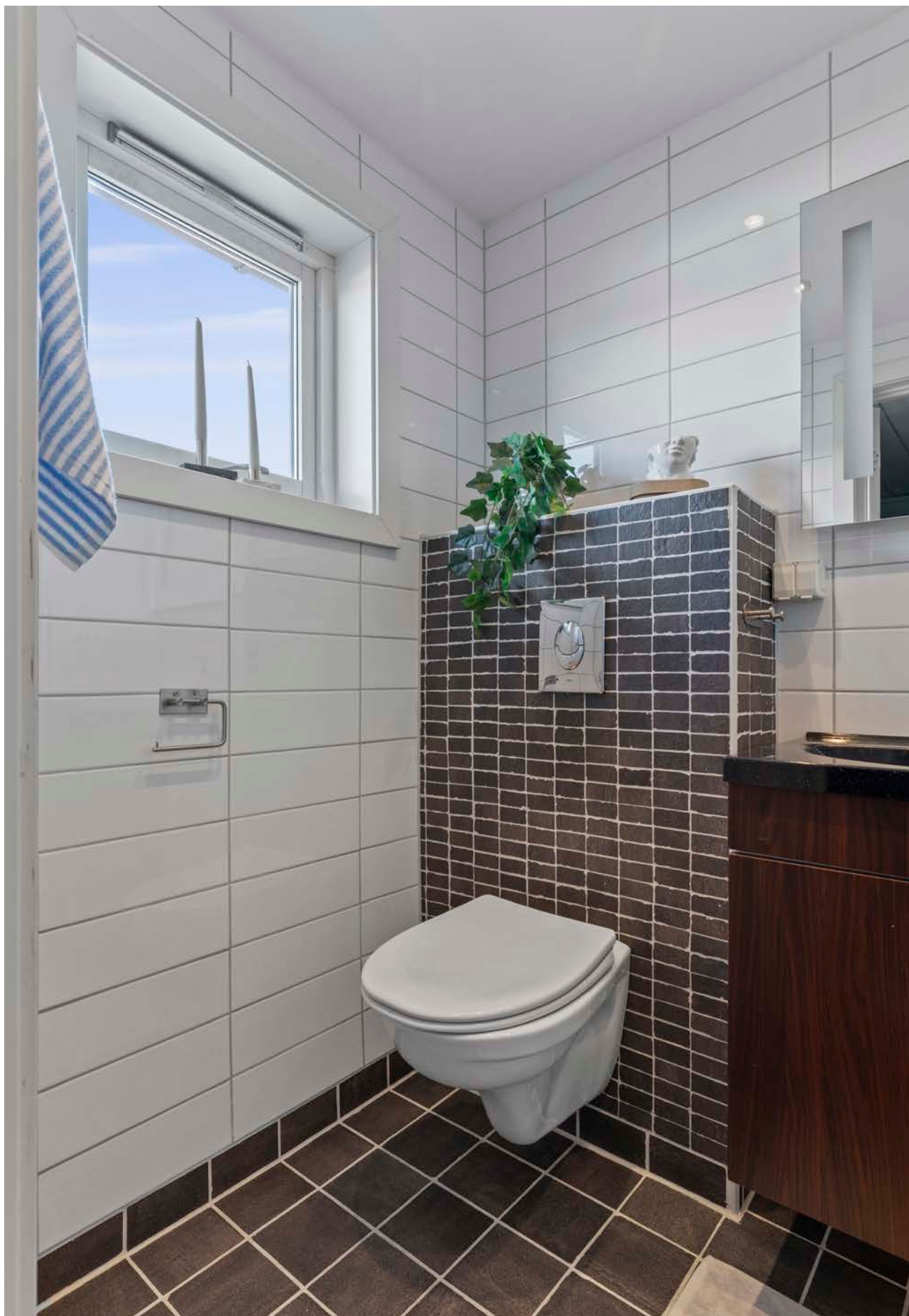
Speil med lys over servant. Vegghengt toalett. Senket og malt platehimling med LED belysning fra 2026. Plastsluk (hovedsluk) under baderomsmøbel og hjelpesluk i dusjhjørne.
