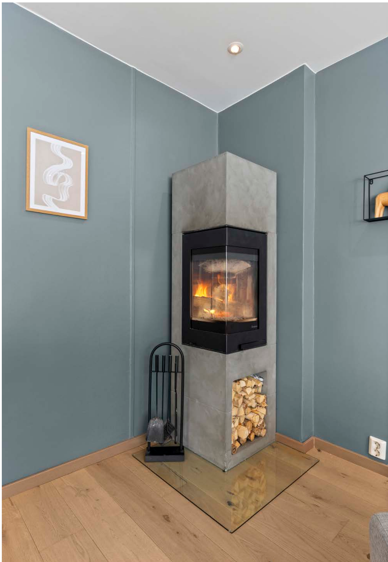
Pipeløp rehabilitert 2018 med ny innvendig stålpipes.
