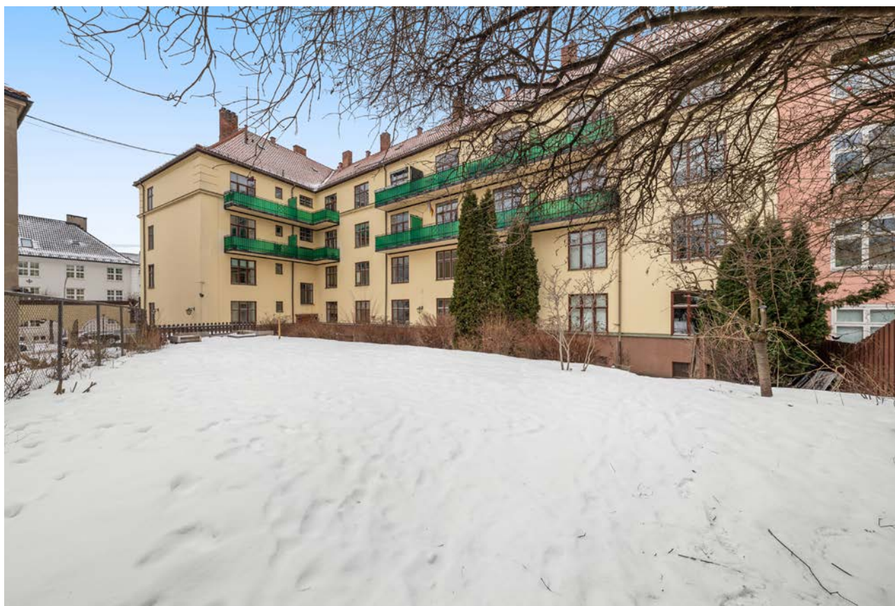
Sørvendt balkong med betongutførelse og stålrekkverk gir solid uteplass.
