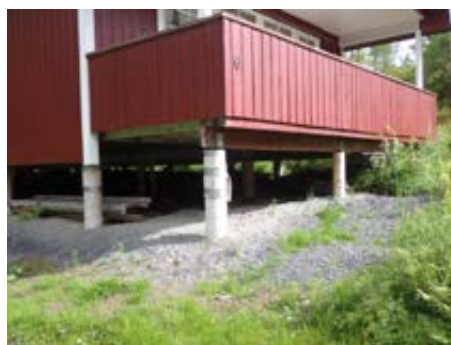
Bilde tatt mot rom under balkong, god lufting under hytta.
