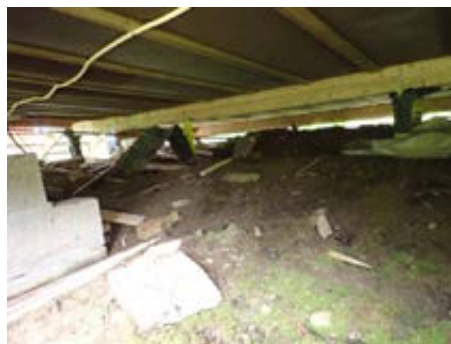
Bilde viser deler av kryprom/ under hytta som også viser deler subbloft mm.
