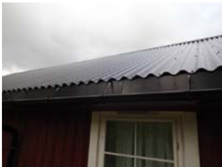
Nærbilde tatt mot yttertak
