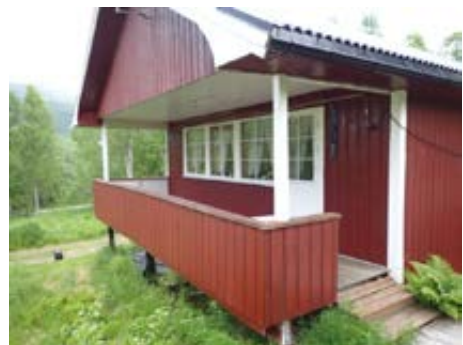
Bilde tatt mot vinduer til gavl stue
