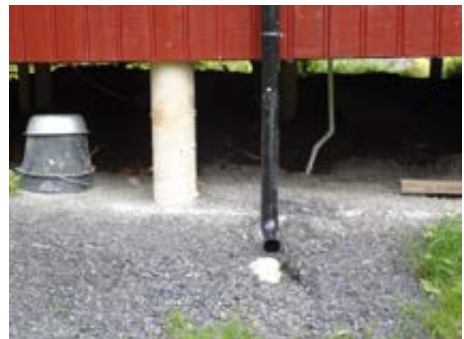
Bilde tatt mot nedløp i midtsone til hytta med utkast
