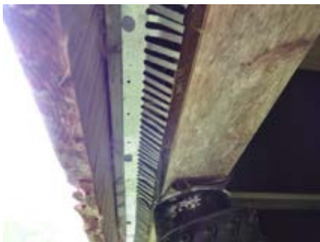
Bilde tatt for å vise at det er etablert musesperre / bånd til hytta
