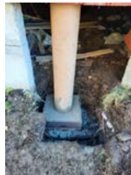
Bilde tatt mot søylefundament under etablering
