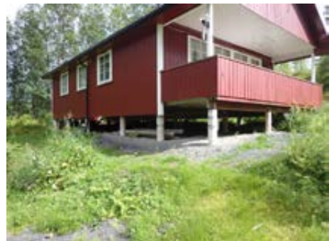
Bilde av fasade viser nedløp i midtsone til hytta ført ned langs vegg mot bakke m/ utkast
