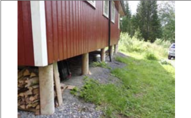
Nærbilde av nyetablert søylefundamenter for hytta utført våren 2026
