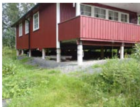
Etablert nye betong søylefundamenter til hytta, utført våren 2026
