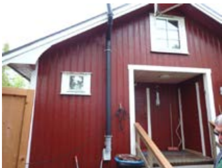
Bilde tatt mot hovedinngangsdør og til sportsbod.
