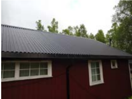
Bilde tatt nært til tak bakside
