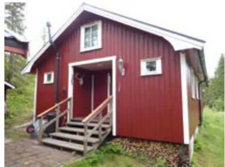
Bilde tatt mot hyttas hovedinngangssone, innhuk mot dør. Salet takform m/ vindu i røst/gavlvegg
