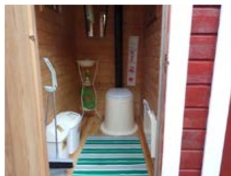
Bilde tatt mot utedo etablert i uthus. Avtrekk over tak, panelovn på vegg. Mindre åpningsvindu etablert
