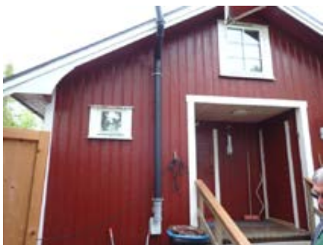
Bilde tatt gavlvegg som viser avtrekk langs vegg og over tak fra innvendige hyttedo i hytta
