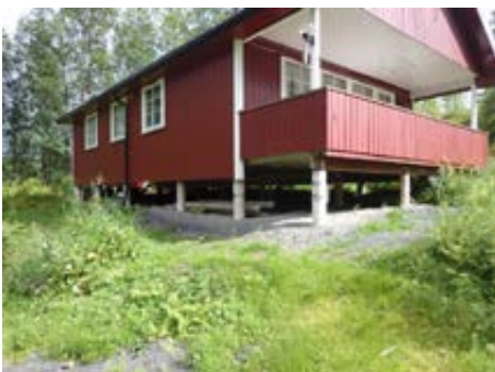
Bilde tatt mot hyttashovedfasade ved adkomst til hytta
