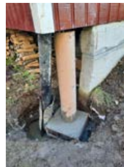
Bilde tatt mot del av forstøtningsmur, nå etablert nye forsterkningssøyler i tillegg til eldre forstøtningsmur.
