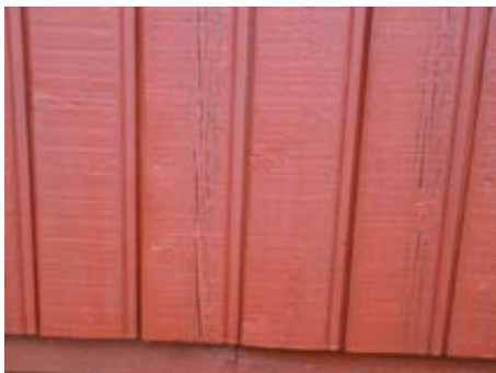
Bilde til deler av kledning som viser riss, sprekker (mindre )
