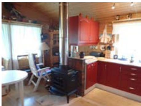
Bilde tatt mot vedfyrte peisovn m/ stålppe ført over tak. vedfyrte ovn etablert i stue / kjøkken sone åpen romløsning
