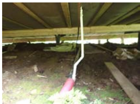
Bilde viser deler av kryprom/ under hytta som også viser deler subbloft mm.
