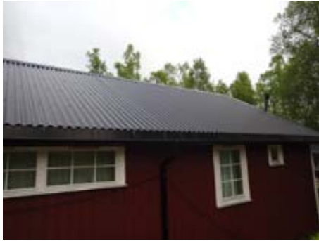
Bilde tatt mot hyttas bakside til tak, renne og (nedløp i midtsoneav hytta)
