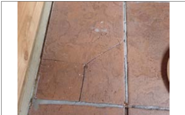
Bilde viser dels sprukne fliser i rommer, er flere fliser som har sprukket, løs og manglende fuging mellom og til fliser
