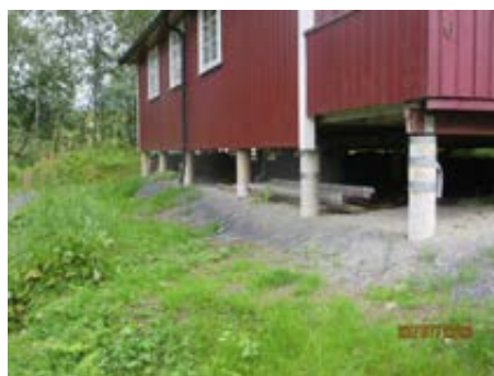
Bilde tatt for å vise rom med god lufting under hytta. Nye betong, søylefundamenter etablert.
