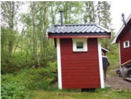
Bilde viser avtrekk fra innvendig hyttedo fra hytta og utedo.
