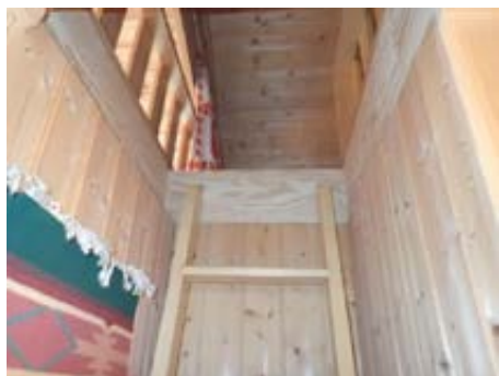
Bilde tatt mot del av trapp opp til hems. Trapp er bratt slik den er i dag.
