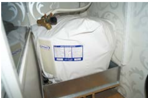
Det er påvist at varmtvannstank er over 20 år
