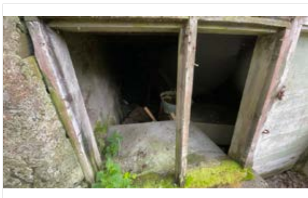
Bilde 10: Bilde tatt gjennom vindu i kjelleretasje.
