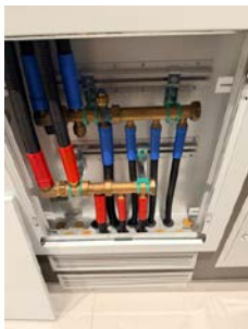
Fordelerskap for badet i kjeller, plassert på soverom.
