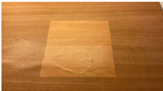
Det er skade på benkeplate (pålimt folie med annen farge over skaden)
