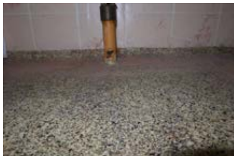
Avtapping fra servantskap.
