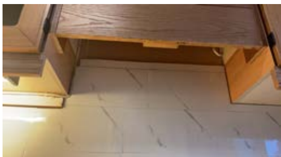
Kjøkkenventilator er fjernet.
