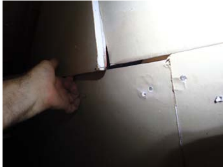
Åpning i plateskjøt brannvegg mot nabo
