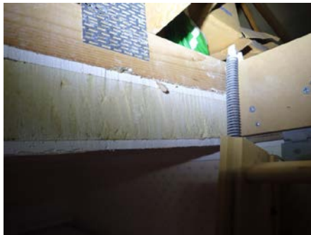
Åpning i plateskjøt brannvegg mot nabo
