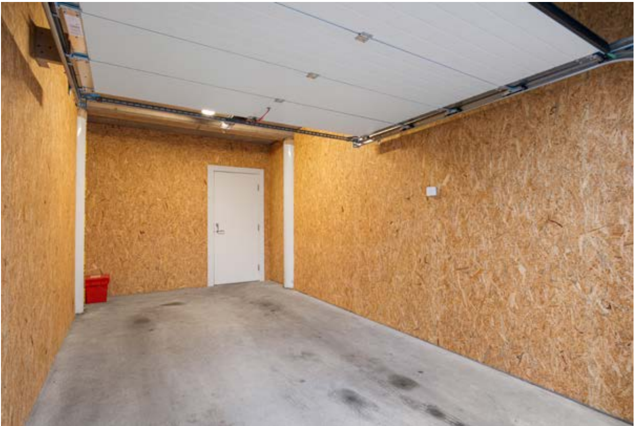
Bod i bakkant av garasje. Det er opplegg for montering av ladeboks til el-bil i garasjen
