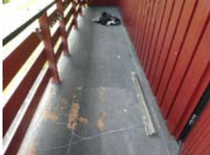
Glassfiberdekke på luftebalkong fra byggeår
