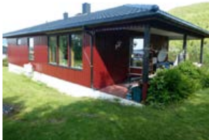
Støpt dekke på overbygget terrasse
