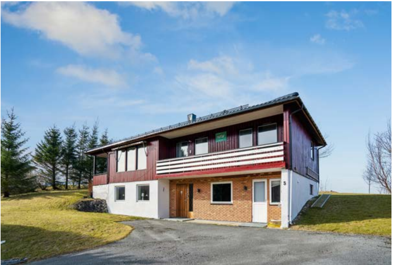
Fasade med inngangspartiet
