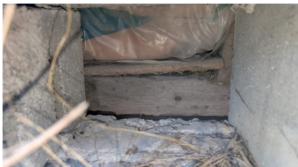
Fra luke i grunnmuren.
