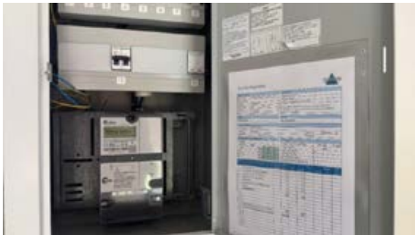
Ny innmat i sikringsskap gjennomført i 2025.
