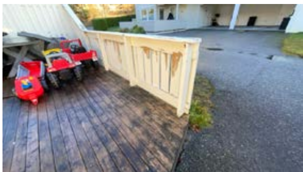
Værslitt rekkverk.
