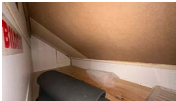
Kottet som var tilgjengelig for inspeksjon. Overflatene er platekledd.
