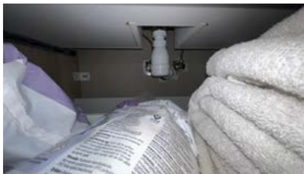
Utett rørgjennomføring gjennom vegg.
