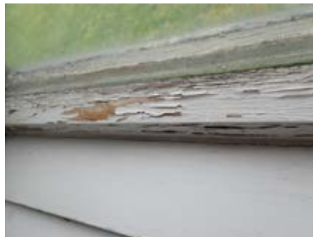
Råteskadet vindu
