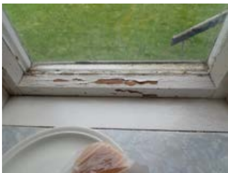
Råteskadet vindu
