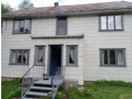
Strekkmestalltrapp fora hovedinngang.
