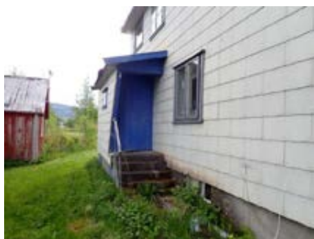
Bi-inngangsdør - defekt
