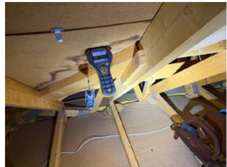
Fuktmåling, ikke utslag på fukt.
