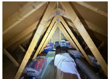
Oversiktsbilde av kaldloftet.
