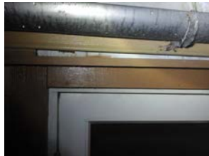
Må sikre mellom vannbord og kledningen.
