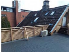
Taket med takterrasen
