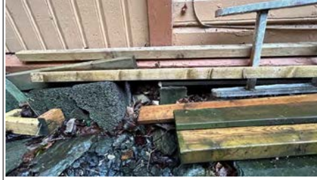
Foto nr. 43 Tettetiltak for rotter påkrevd.
