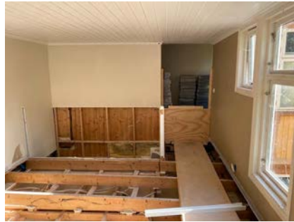
Bilde viser i tilbygg som det er revet og inngang mot hovedbygg.
