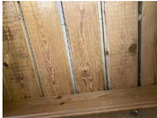
Bilde er tatt inne i næringsdel opp mot 1. etg og viser gulvbord med overliggende trinnlydplater
