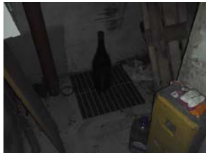
Midlertidig sikring av sluk
