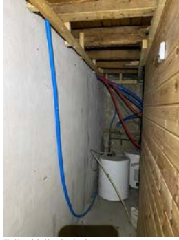
Felles kjeller isolasjon revet
