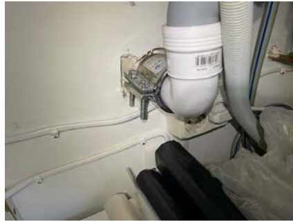
Strømføring er montert på utsiden av vegg mot seksjon 3
