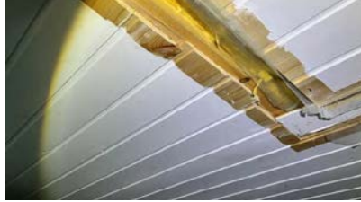
Himling / yttertak under terrasse for 3.etg.
