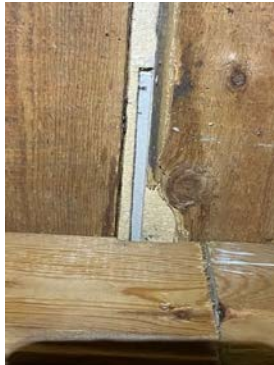
Bilde er tatt fra fellesdel i kjeller og viser overliggende trinnlydplater + gips over der igjen. Som stemmer med oppbygging fra akustikkplan
