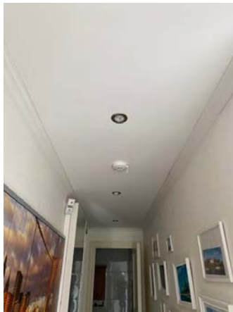
Spotter i taker har perforert himlingen mot seksjon 5 i tilbygget.
