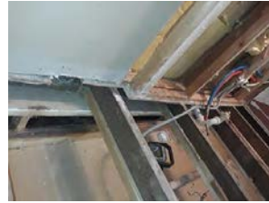
Det er åpnet gulv 2 etasje
