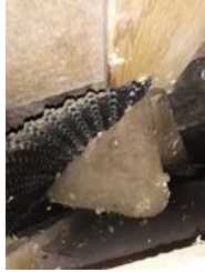
Ned i vegg 2 etasje
