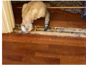
Det er under denne terskel lyder ble observert.
