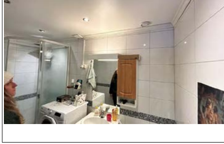
Foto nr. 40 Bad med downlights i himling opp i bjelkelag mot 2.etg.
