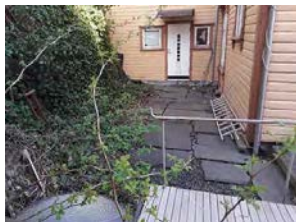
Potensielle inntreksveier rundt hele huset
