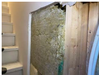
Mot gang/bad seksjon 3 1. etg – vegg med to lag gips på begge sider og isolert med rockwool
