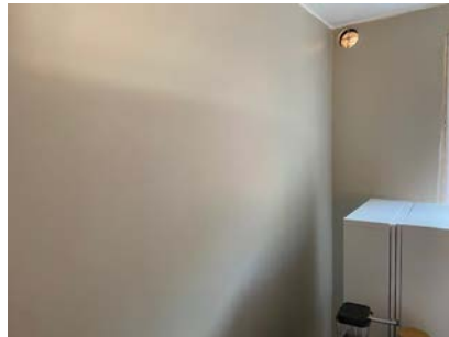
Vegg mot seksjon 4 i hovedbygg. Ingen gjennomføringer men må åpnes her pga avvik i etasjeskiller ref bilde brannrapport.
