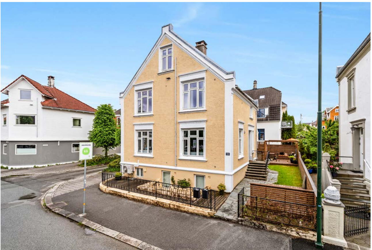
Nydelig fasade, vinduer fra 2024
