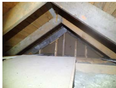
Ingen ventil i røstvegg
