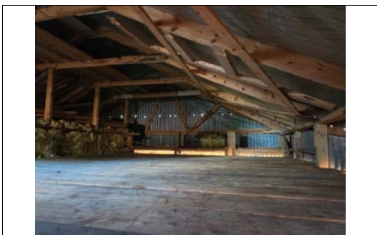
Bilde fra hems/loft over biloppstillingsplass. Ikke målverdig pga. lav takhøyde.
